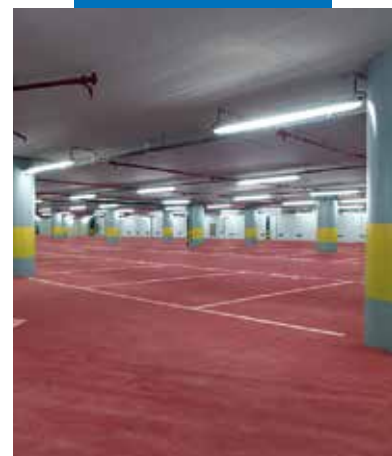
Berlaymont Building, Brüssel - Belgien Ultratop rot
