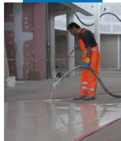
Applikation mit Mörtelpumpe
