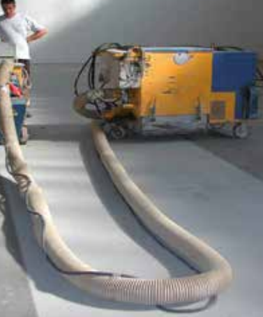
Untergrundvorbehandlung im Kugelstrahlverfahren
