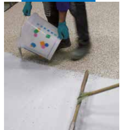
Auftragen von Ultratop auf den vorbereiteten Untergrund mit natürlichen Zuschlägen und Mapefloor I 910
