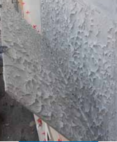
Hervorragende Benetzung zwischen Untergrund und Plattenrückseite
