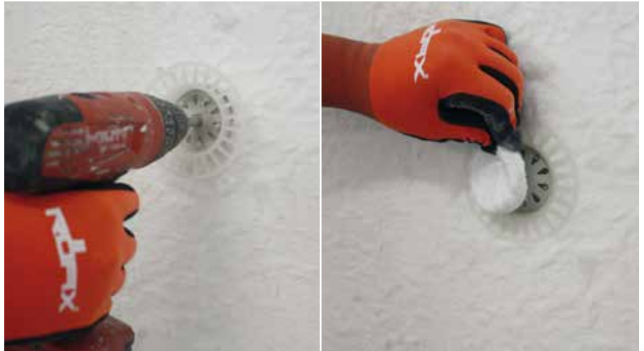
Ab 60 mm DD Dübel mit Versenksteller versenken Dübel mit ausgenommener Rondelle abdecken
