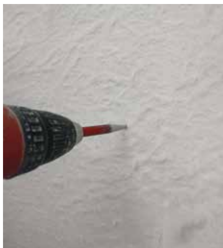
Dübellöcher mit Körner vorbereiten und erstellen
