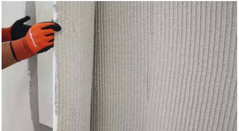
Dämmplattenverklebung im Buttering-Floating-Verfahren
