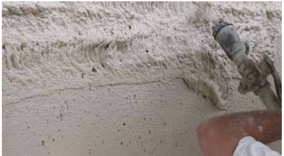
Putzapplikation mit handelsüblicher Putzmaschine
