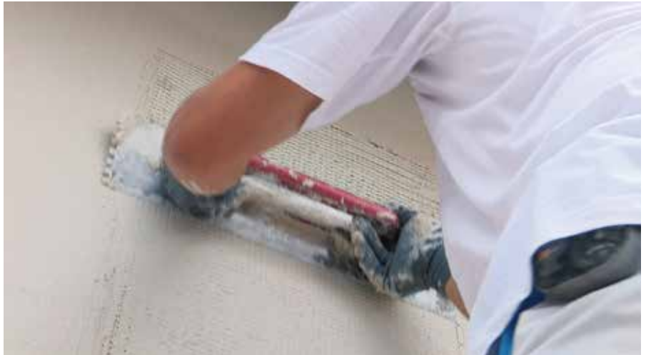
Gewebeeinbettung mit Armiermörtel
