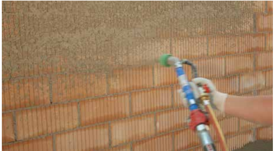
Untergrundvorbereitung mit handelsüblicher Putzmaschine
