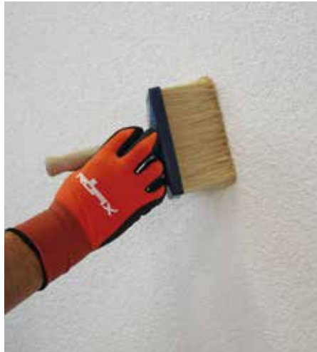
Tragfähigen Untergrund herstellen
