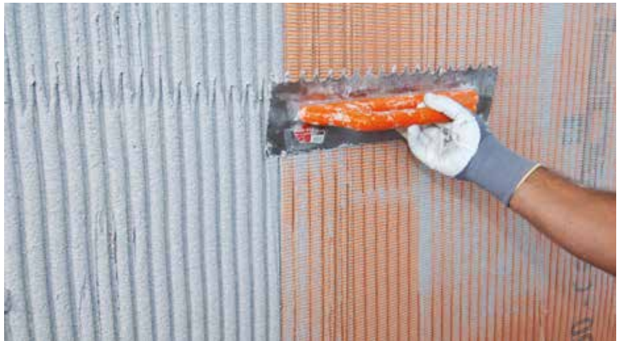
Erstellung des armierten Unterputzes
