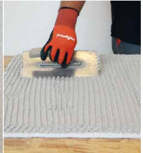
Kleberauftrag im Buttering-Floating-Verfahren
