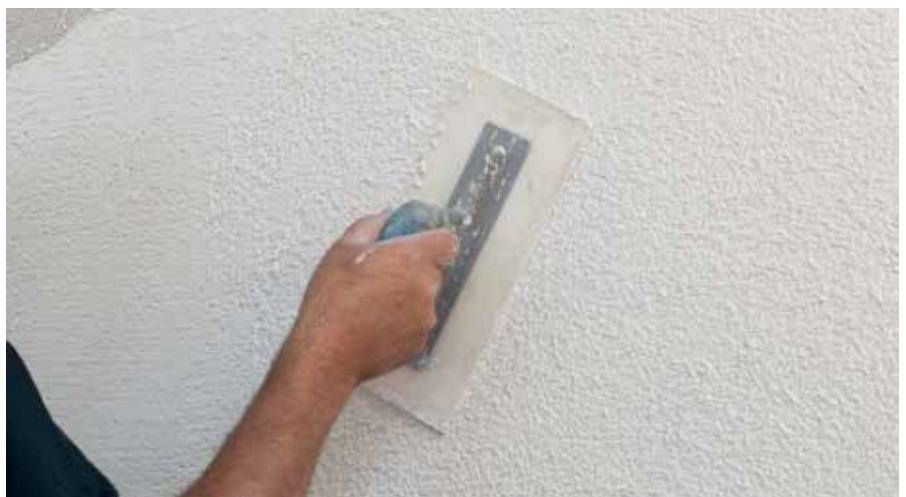
RÖFIX Oberputz auftragen und nach Wunsch strukturieren
